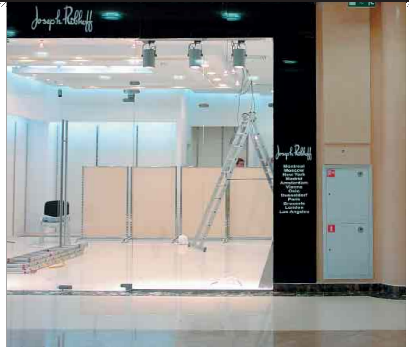
ДО НАЧАЛА РЕМОНТНЫХ РАБОТ НЕОБХОДИМО СОГЛАСОВАТЬ С УК ДИЗАЙН-ПРОЕКТ.
